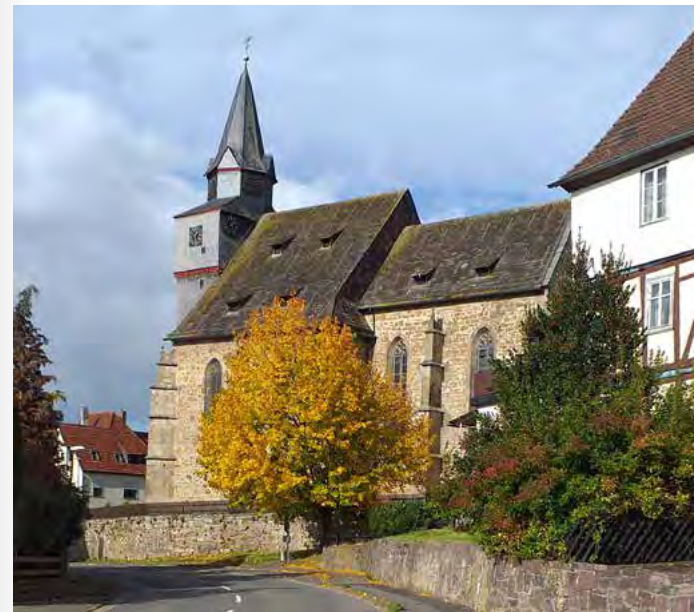
Wallfahrtskirche in Gottsbüren
